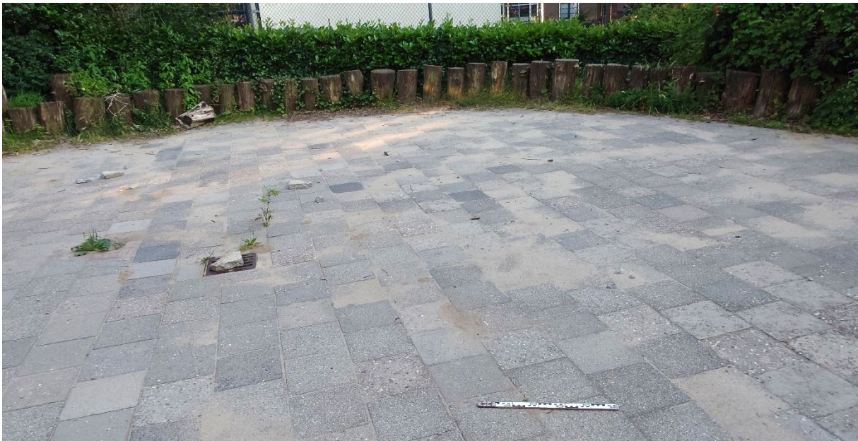
Figuur 9 Spoor 1 - Straatwerk van het cirkelvormige plein, bestaande uit 30x30 tegels à 9,5 kilo. Foto genomen in grofweg zuidelijke richting.
