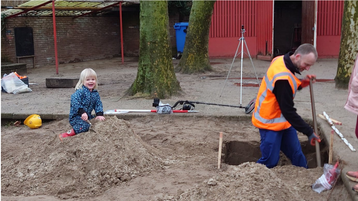
Figuur 18 Sfeerfoto van de werkzaamheden.
