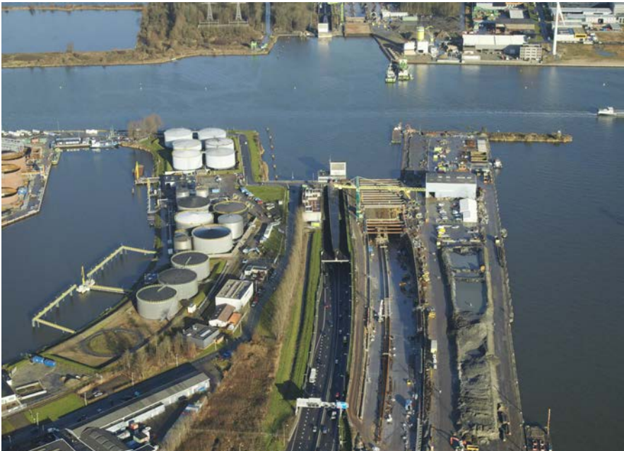
25. Bouw van de Tweede Coentunnel, geopend 2013.
